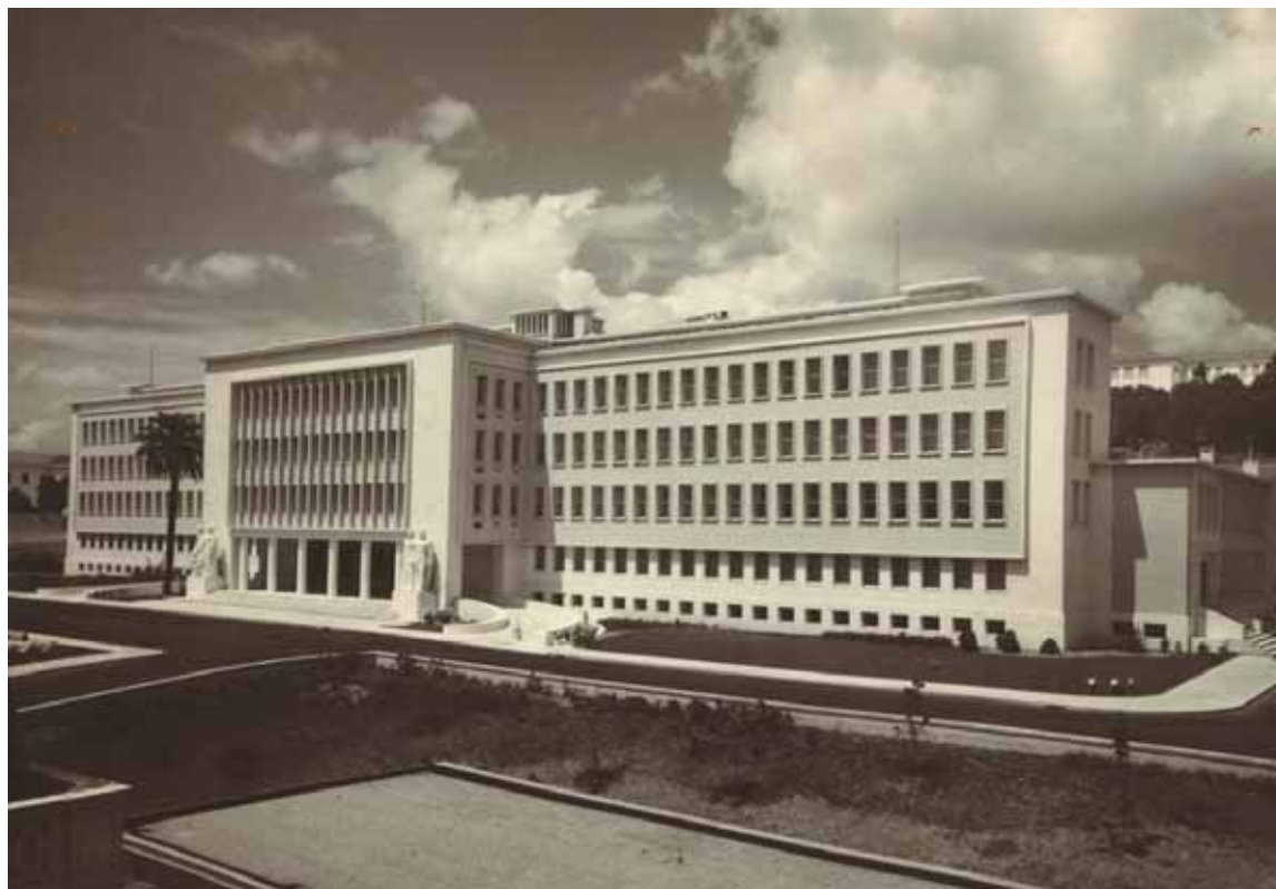
IHMT.0000339. Edifício. Instituto de Medicina Tropical. Junqueira.
